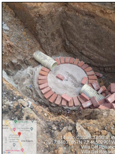
EXCAVACION E INSTALACION TUBERIA ALCANTARILLADO SANITARIO
