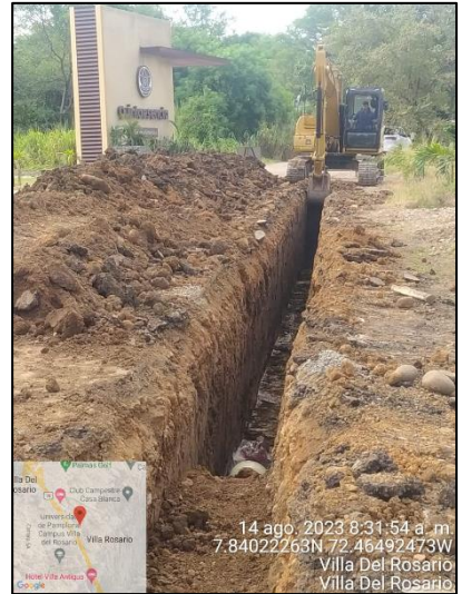
EXCAVACION E INSTALACION TUBERIA ALCANTARILLADO SANITARIO
