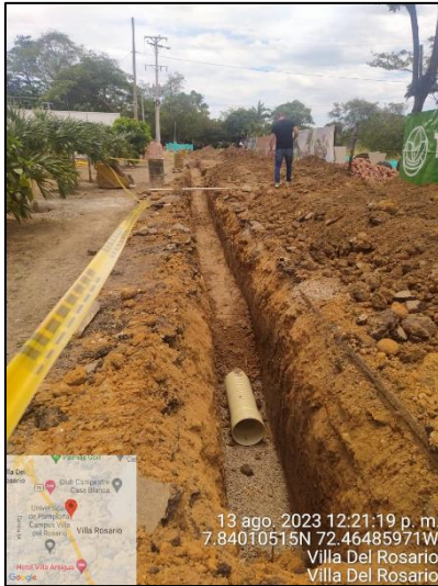
EXCAVACION E INSTALACION TUBERIA ALCANTARILLADO SANITARIO
