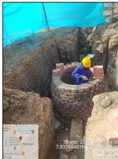
CONSTRUCCION POZOS DE INSPECCION
