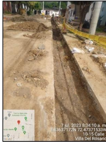
Relleno material excavacion y base
