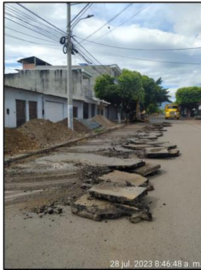
Corte y demolición de pavimento
