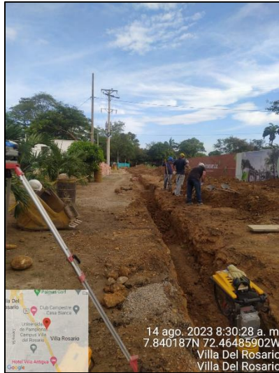
EXCAVACION E INSTALACION TUBERIA ALCANTARILLADO SANITARIO
